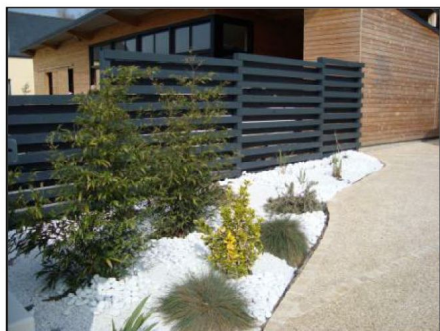
Clôture à claire-voie
