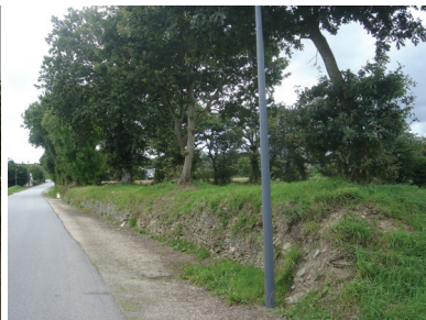
S'inspirer du paysage : un talus-mur en centre-bourg
